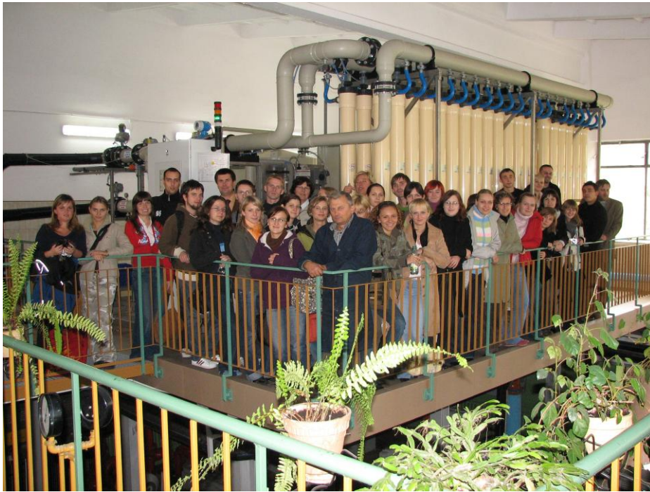
Fotografia 1. Wyjazd szkoleniowy Sucha Beskidzka 20 października 2006 (w tle membrany filtrowe)
